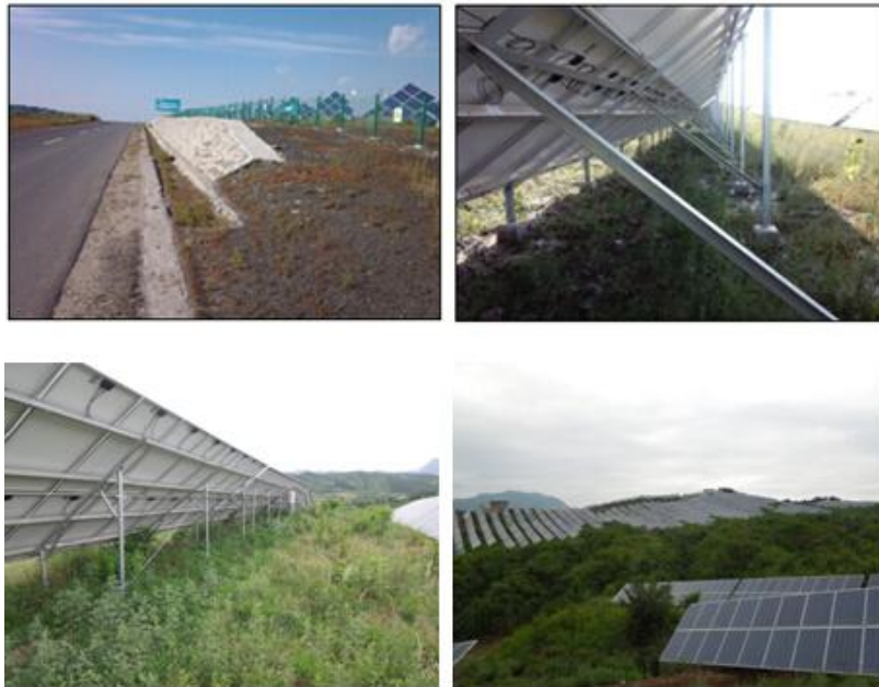
图 5-1 场区外排水沟与光伏基础
