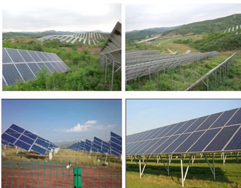
图 5-2 光伏场区植被情况
